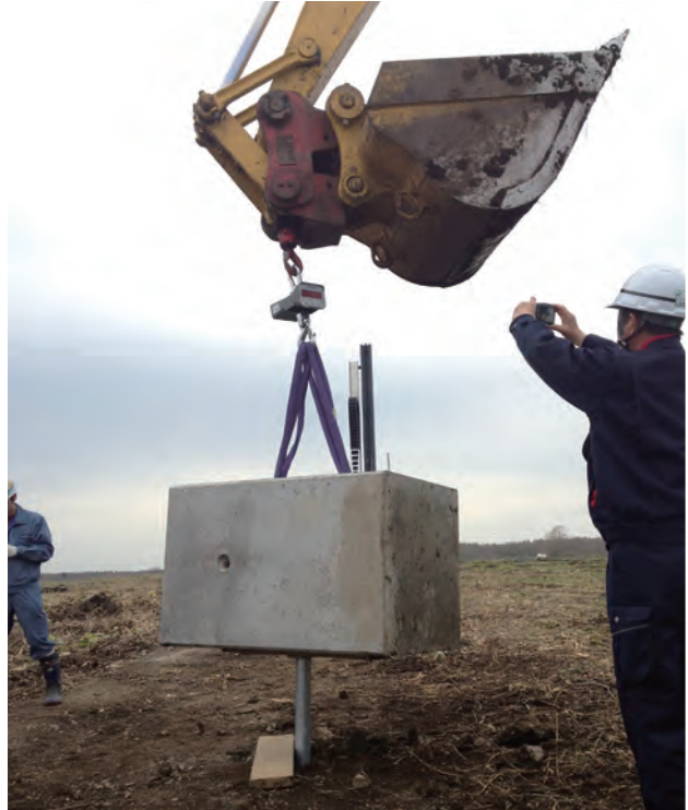
荷重試験 1,924Kg/ 杭 1 本 (外径 76 mm、打込み 1,600mm)
