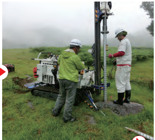
グラウンドスクリュー杭ねじ込み
